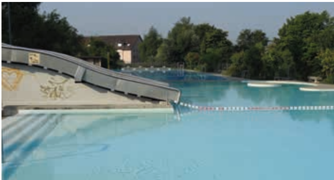
Die Folien im Schwimmbad sind undicht
