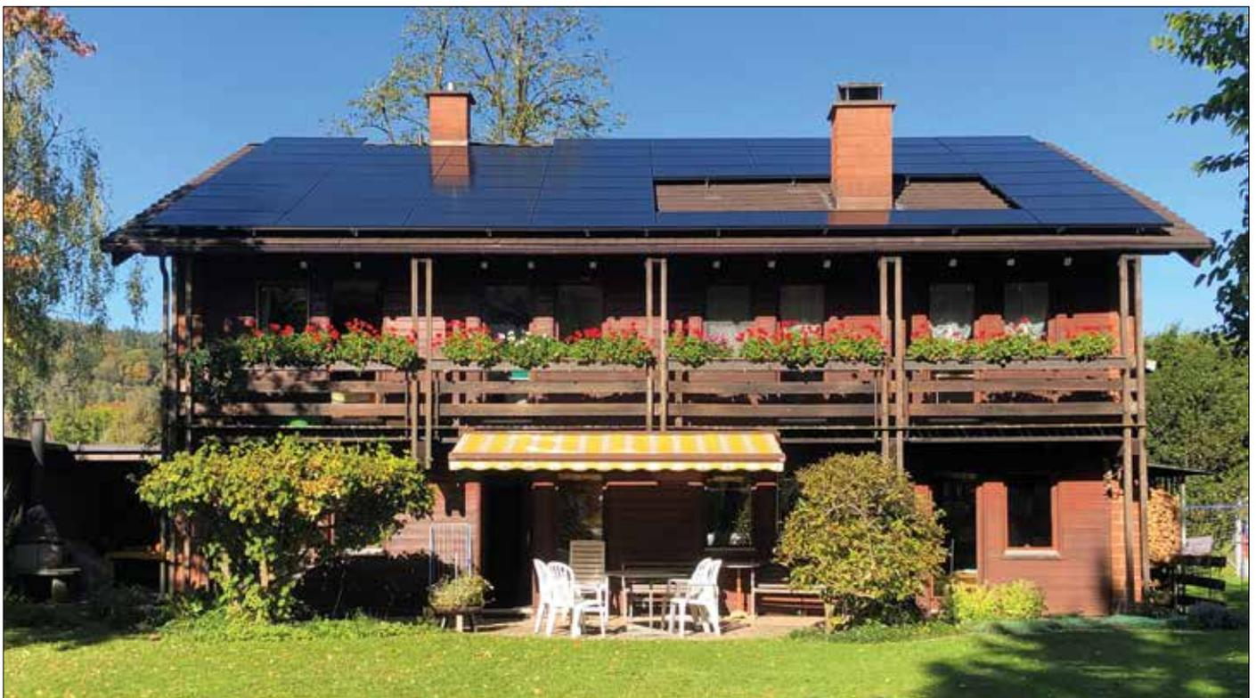
*Neu installierte Fotovoltaikanlage an der Rankstrasse 19. 53 Panels erzeugen auf einer Fläche von 86 m<sup>2</sup> maximal 16 kWp. Pro Jahr können rund 15000 kWh erzeugt werden, etwa das 4fache des Haushaltstromverbrauchs. Eine Batterie mit 4,6 kWh Speicherkapazität erweitert den Eigenversorgungsgrad. Mit den gegenwärtigen Rückspeisetarife kann die Anlage nicht in vernünftiger Zeit amortisiert werden.*
