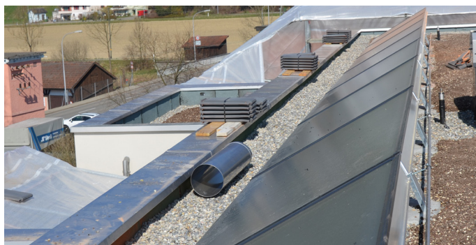
Abbildung 5: Für diese Anlagen braucht es eine Bewilligung, da sie entweder mehr als 20 cm über die Dachfläche ragen (links) oder nicht in einer zusammenhängenden Fläche angeordnet sind (rechts).
