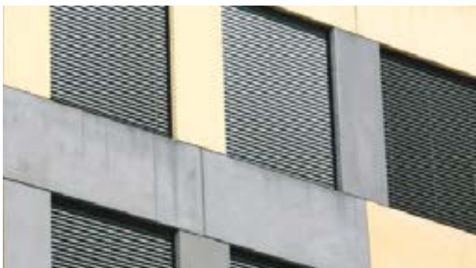
Lamellenstoren können das Tageslicht nicht nur dosieren, sondern durch Schrägstellen der Lamellen bis zu einem gewissen Grad auch lenken.
