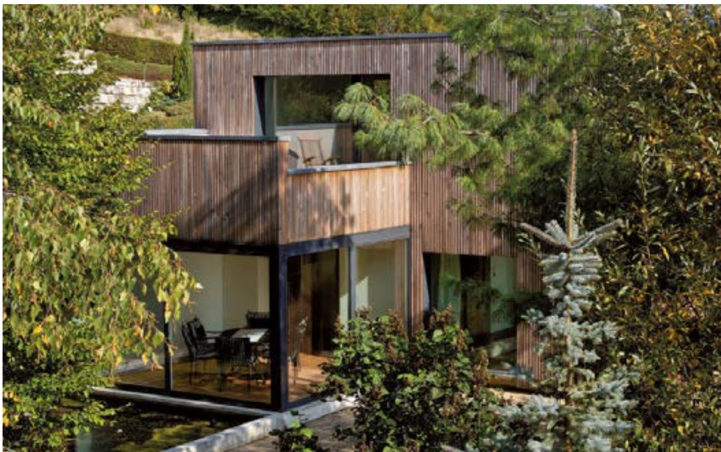
Wer bei der Sanierung wie bei diesem Minergie-Einfamilienhaus in Gorgier – Chez-le-Bart die Fensterflächen vergrössert, sollte gleichzeitig auf einen guten sommerlichen Wärmeschutz achten. Quelle: Peter Brunner – Architecte ETS-UTS, Neuchâtel
