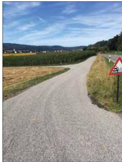
Das PWI-Projekt zur Sanierung unserer Asphaltstrassen mit Heissbindemittel und Splittabdeckung wurde Anfang 2020 von der Baudirektion bewilligt und in drei Etappen realisiert.
