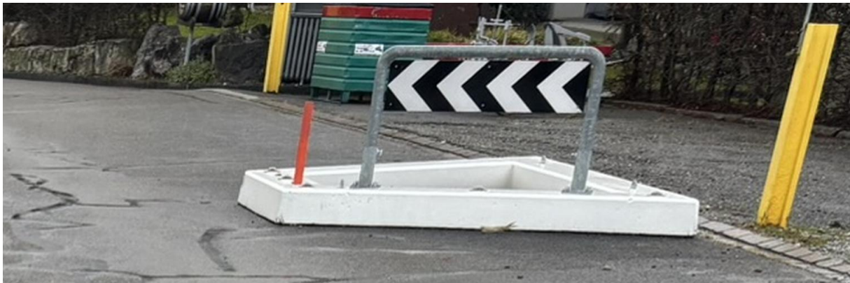
Abb. 6: Foto einer bestehenden Einengung (Typengleich)
